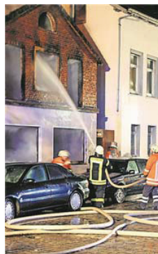
Im Oktober waren Feuerwehrleute mit einem großen Aufgebot in die Wilhelm-Heidsiek-Straße gefahren, aber das brennende Gebäude war nicht mehr zu retten. Foto Koppe
